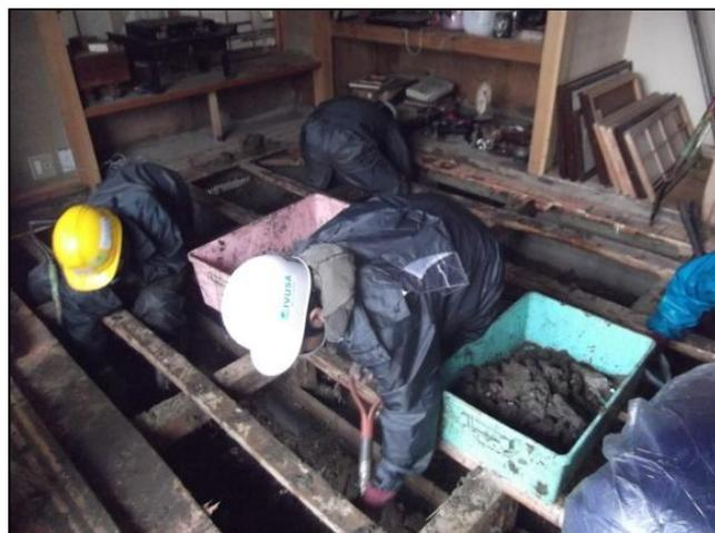
写真6 床下のヘドロを掻きだしている様子
