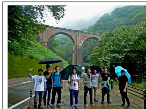
内田班：碓氷峠第3橋梁（通称：めがね橋）下にて（橋上にも2人います）
