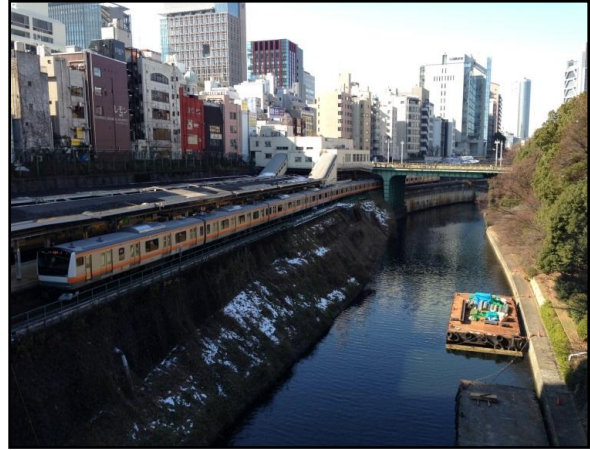
写真2. 聖橋から見たJR中央線・総武線と外堀
