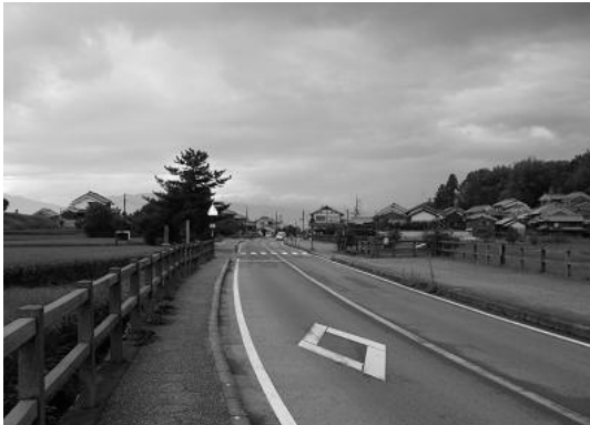
写真2 川原寺跡の電柱・電線地中化の様子 (道路と平行方向に筆者撮影)
