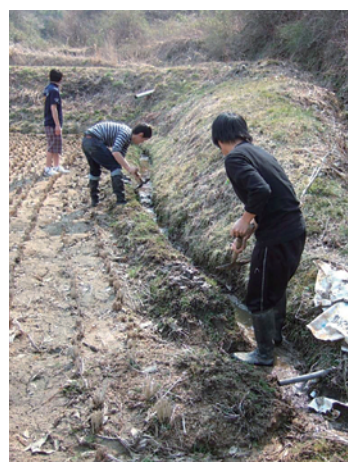
写真4 溝掘り作業
